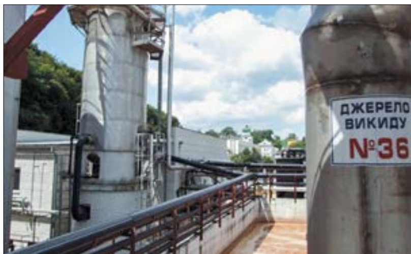
Oczyszczalnia ścieków we Lwowie
