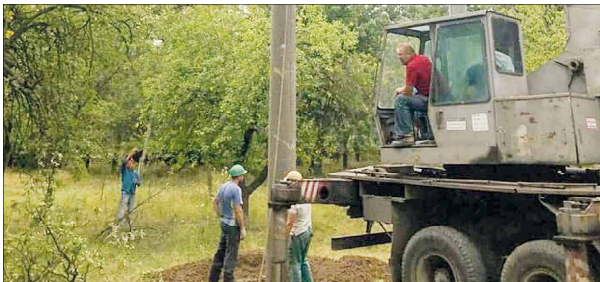
Plany przywrócenia Dzygówcę figury Madonny stają się rzeczywistością. Pod koniec lipca przy użyciu dźwiga została zainstalowana betonowa kolumna, na której niedługo ma stanąć figura Matki Bożej
