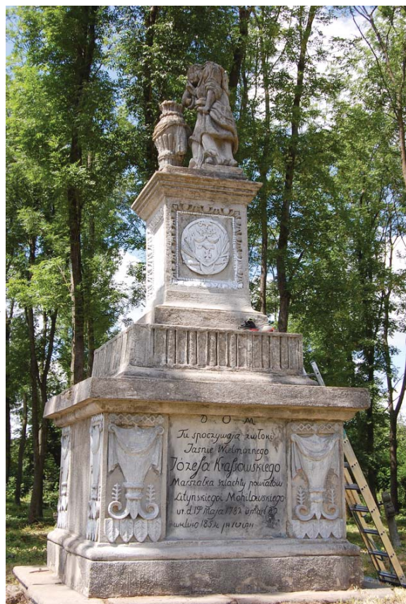
Efekty pracy wolontariuszy z Dolnego Śląska są widoczne już z daleka
