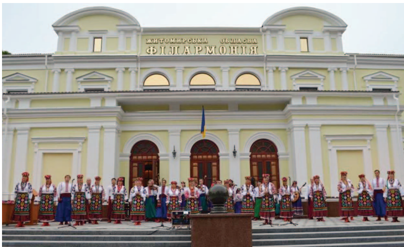
Żytomierska filharmonia po remoncie
